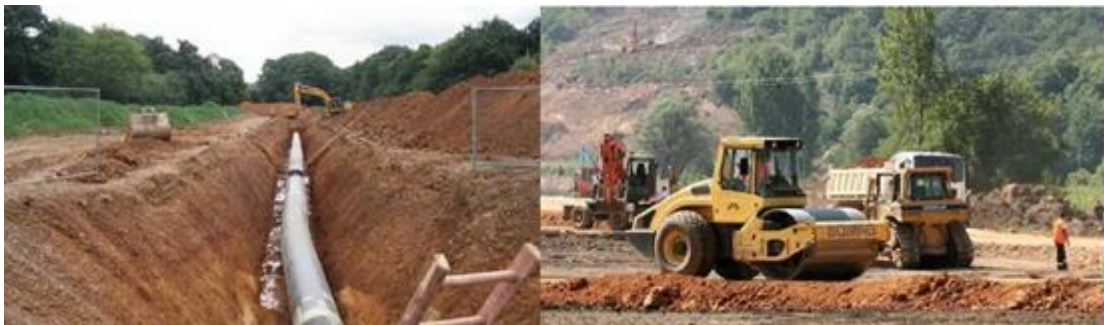
Слика 6.5: Приказ земљаних радова и полагање гасовода Извор: Фотодокументација ЈП Србијагас-а
